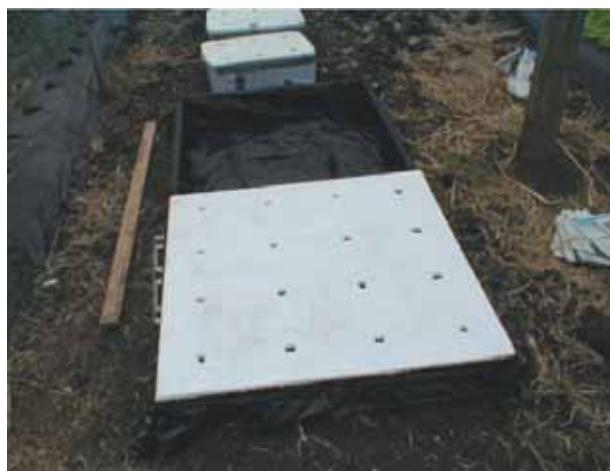
Foto 9 Plancha de poliuretano perforada
