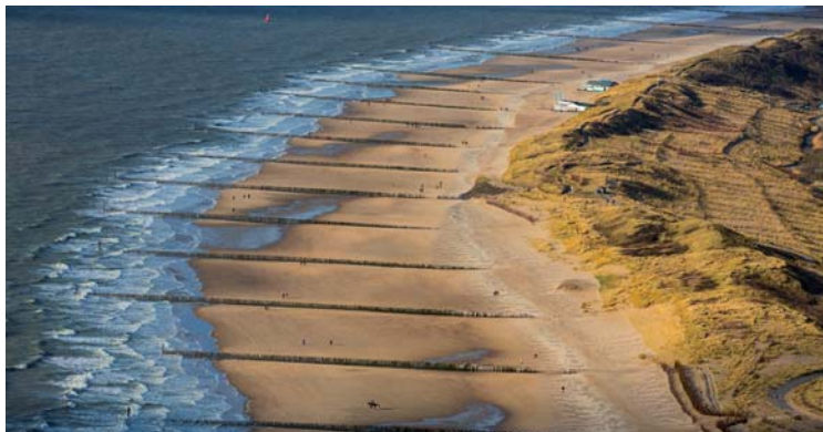
Holanda. Pilotes contienen la arena en la isla Walcheren. Una obra fundamental.
