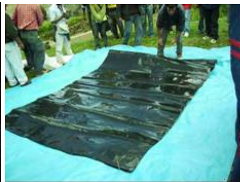
Fig. 9 Extendido de polietileno
