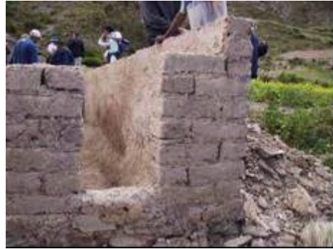
Fig. 6 Zanja para tubería en estructura de adobe
