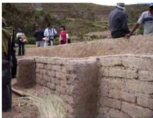
Fig. 4 Estructura de adobe con soportes de seguridad.
