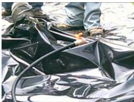
Fig. 14: Instalación de manguera y llave de paso
